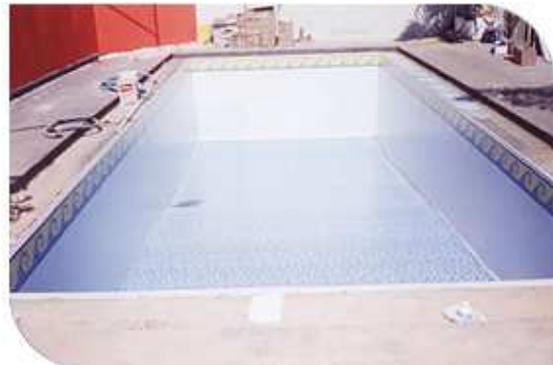
No estágio subsequente, as flanges dos dispositivos finalmente serão instalados ; assim como a do ralo de fundo que já deverá estar submerso nesta etapa para a colocação da guarnição e fixação dos parafusos ; onde será utilizado um estilete para uma incisão em X no centro do orifício do dreno para a desobstrução definitiva do fluxo de água.
