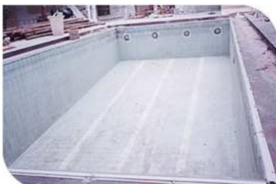
Na próxima imagem, observa-se o procedimento de instalação do bolsão de vinil devidamente dimensionado pelas cotas das medidas da piscina.
