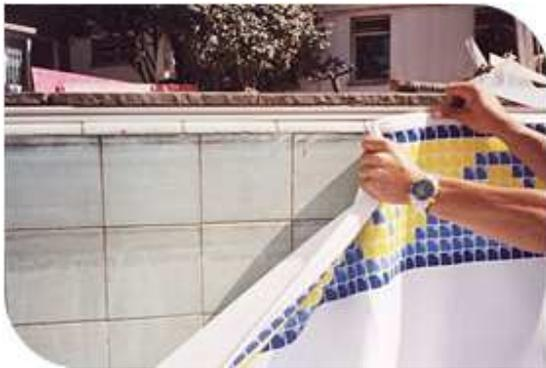
A instalação consiste em encaixar a fita dentada; localizada na extremidade da manta de vinil ; ao perfil até que se complete o perímetro.
