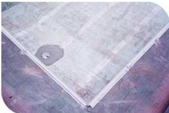
Antes de rebocar com massa fina, deve-se colocar os pedaços de fita para cobrir os orifícios com roscas na base das canoplas para evitar que o reboco penetre e evite problemas de fixação dos parafusos nas conexões das flanges evitando futuros vazamentos.
